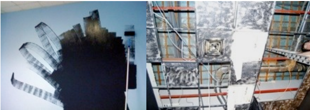
Εικόνα 30 : Βάψιμο δωματίου (αριστερά) - Μορφοποίηση οροφής δωματίου (δεξιά).
