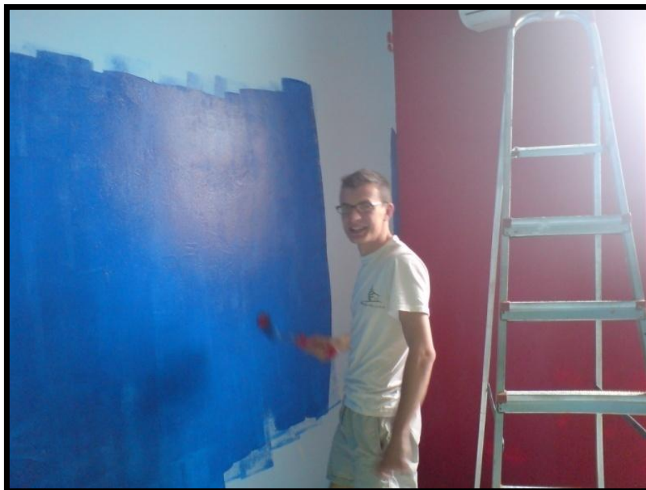
Εικόνα 3.19: Στήσιμο της εγκατάστασης
